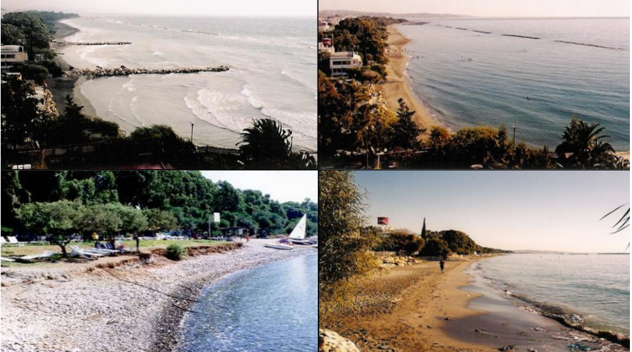
Resim 1. Kıyı duvarının yıkılması, Limasol- Germasogeia- Kıbrıs (Fotoğraf, Xenia Loizidou).
