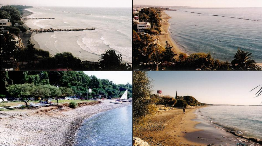
Φωτογραφία 2. Κατεδάφιση κάθετων προβόλων στη Λεμεσό της Κύπρου και αντίδραση της ακτής (Φωτογραφίες Ξ.Ι. Λοϊζίδου).
