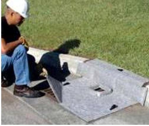
Resim 2. rögar kapakları (kanaldan dakikada metrekare başına 750 litre su geçmesini sağlar ) [9].
