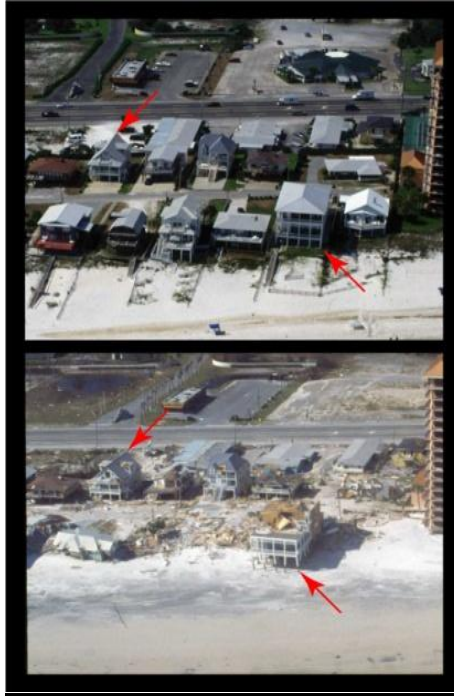
Resim 3. Katrina Kasırgası sonrası çıkan fırtına dalgalanmasının sonuçları- Orange Beach,Alabama. Oklar fırtına öncesi ve sonrası binaların durumunu göstermektedir.(Resimler, USGS )
